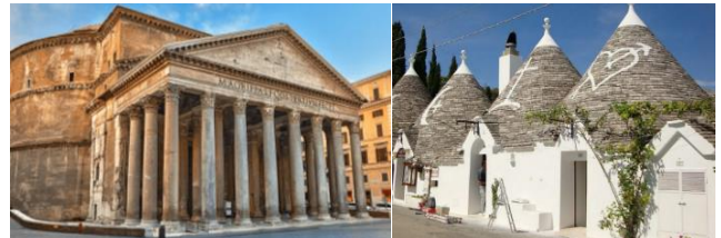
写真1 パテオン外観
